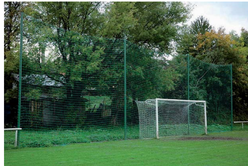
nové, síťované zábrany – léto 2007
